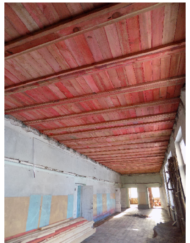
Новые деревянные перекрытия
