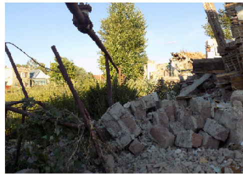
В непосредственной близости от газопровода
