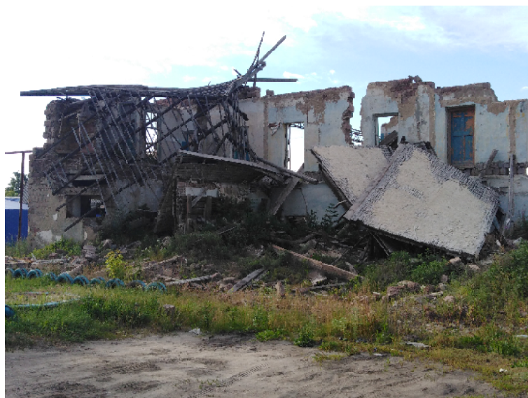
Ленина, 36. «Строительный мусор» до демонтажа
