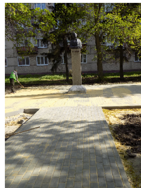
К проведению Пушкинского праздника сквер почти готов
