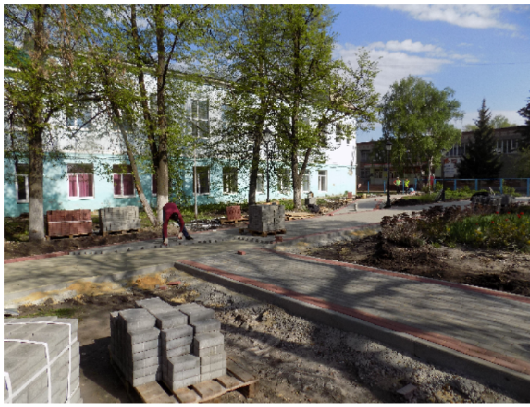
Плиточка к плиточке...
