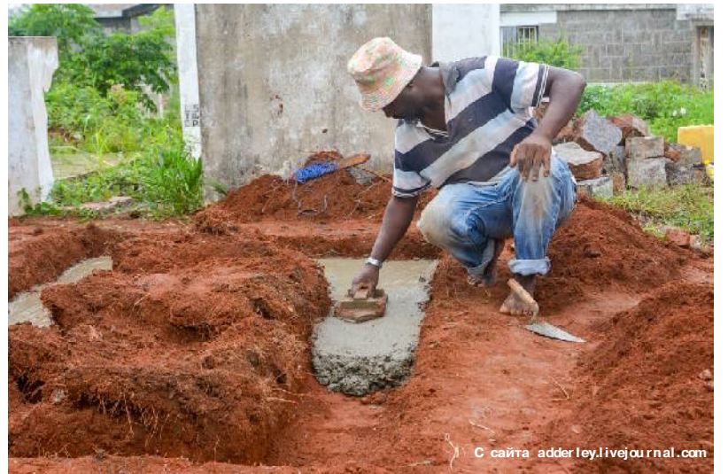
Работы по реконструкции могилы Григория Олсуфьева
