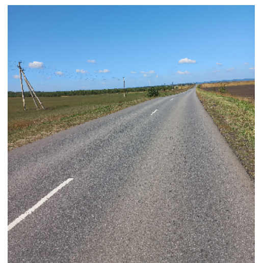
Сосновоборский район. Ремонт обеих дорог производился практически одновременно
