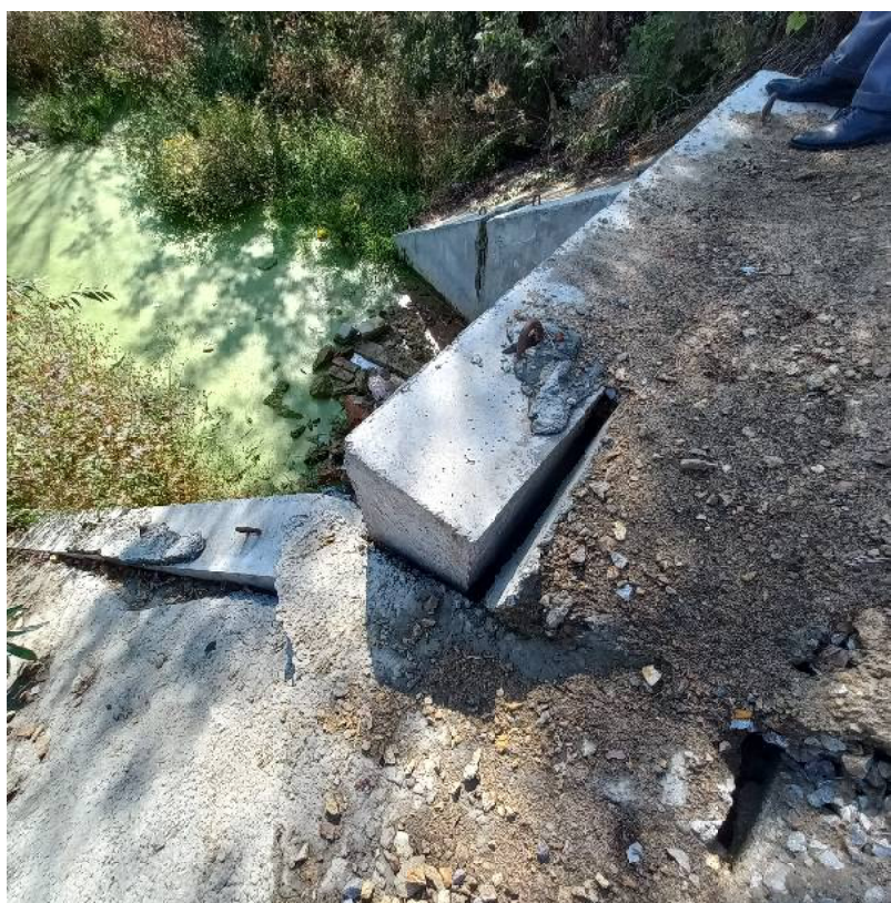
Так выглядит обочина дороги, находящейся в эксплуатационном состоянии
