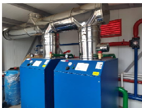
Новая модульная котельная на ул. Октябрьской
